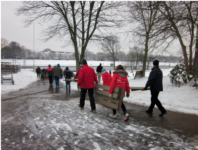
Arbeiten im Schnee: Herantragen der Beplankung
