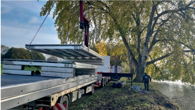
Abladen der Stegteile
