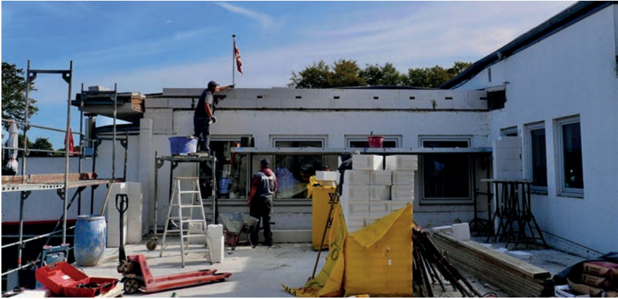
Am 17. September wird die Altbauwand aufgemauert
