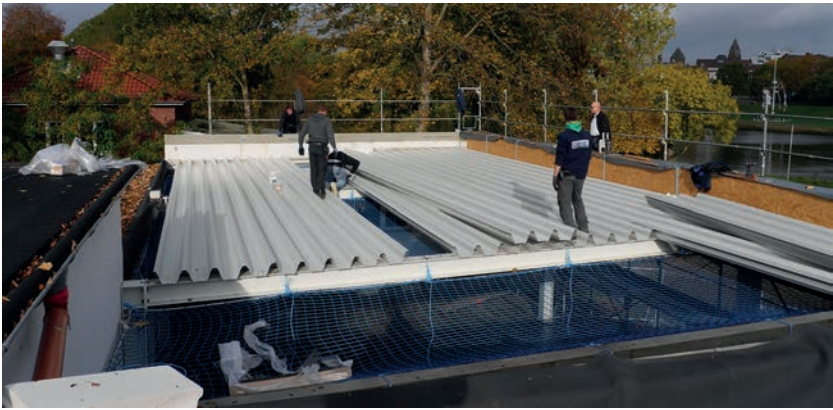
Am 28. Oktober erfolgte der Einbau der Trapezbleche durch die Dachdecker
