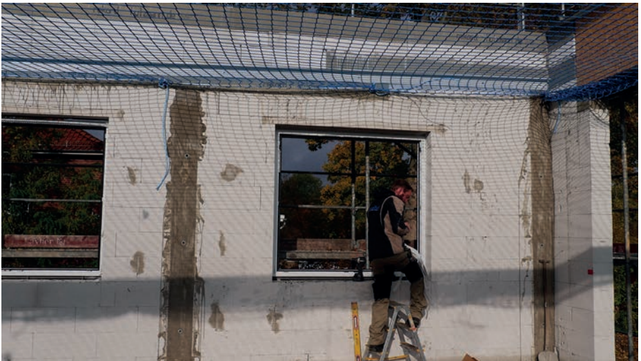
Am 27. Oktober erfolgte der Einbau der Fenster
