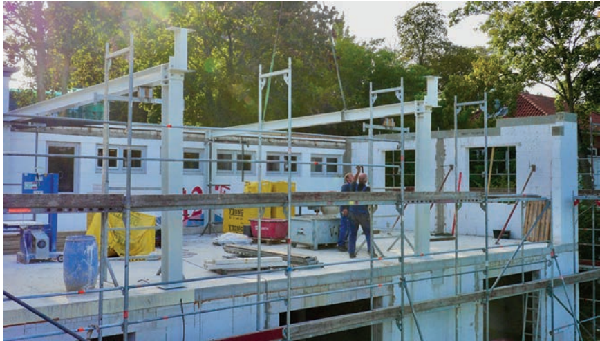
Am 17. September werden auch die Stahlrahmen eingebaut
