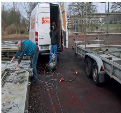
Handwerker bei der Arbeit
