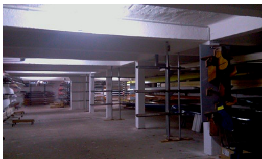
Ein Blick in die Bootshalle nach dem Einbau der neuen Bootsager
